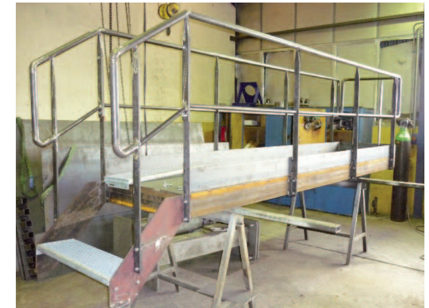
Réalisation au sein de l'atelier de serrurerie Cegelec à Os-Marsillon.
