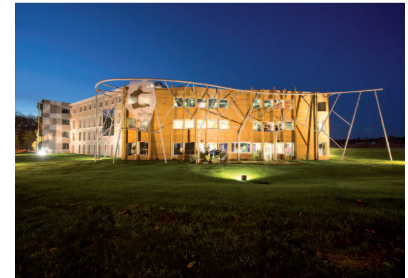
Bâtiment Sud Europe à Pau : Immeuble de bureaux et d'activités.
